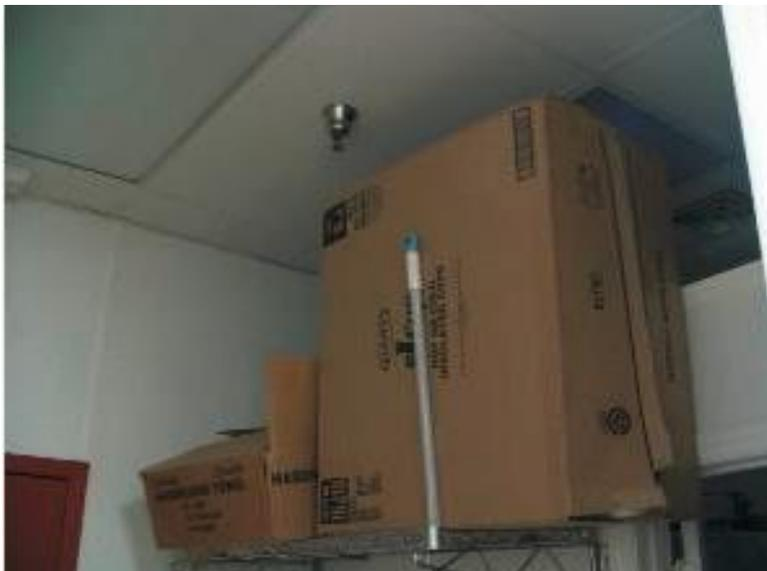
Rociador con descarga obstruida por altura de almacenaje inadecuado
