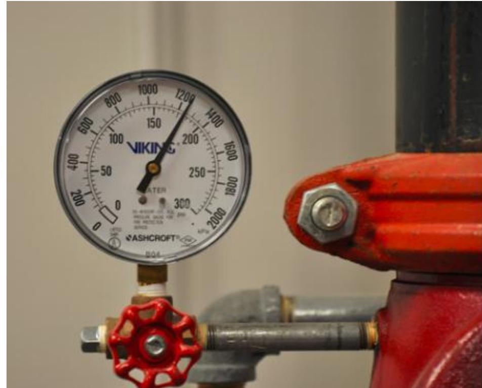
Los manómetros deben controlarse cada 5 años y testarse con patrón calibrado. Los manómetros de sistemas secos, pre acción e inundación verificarse **SEMANALMENTE**.
